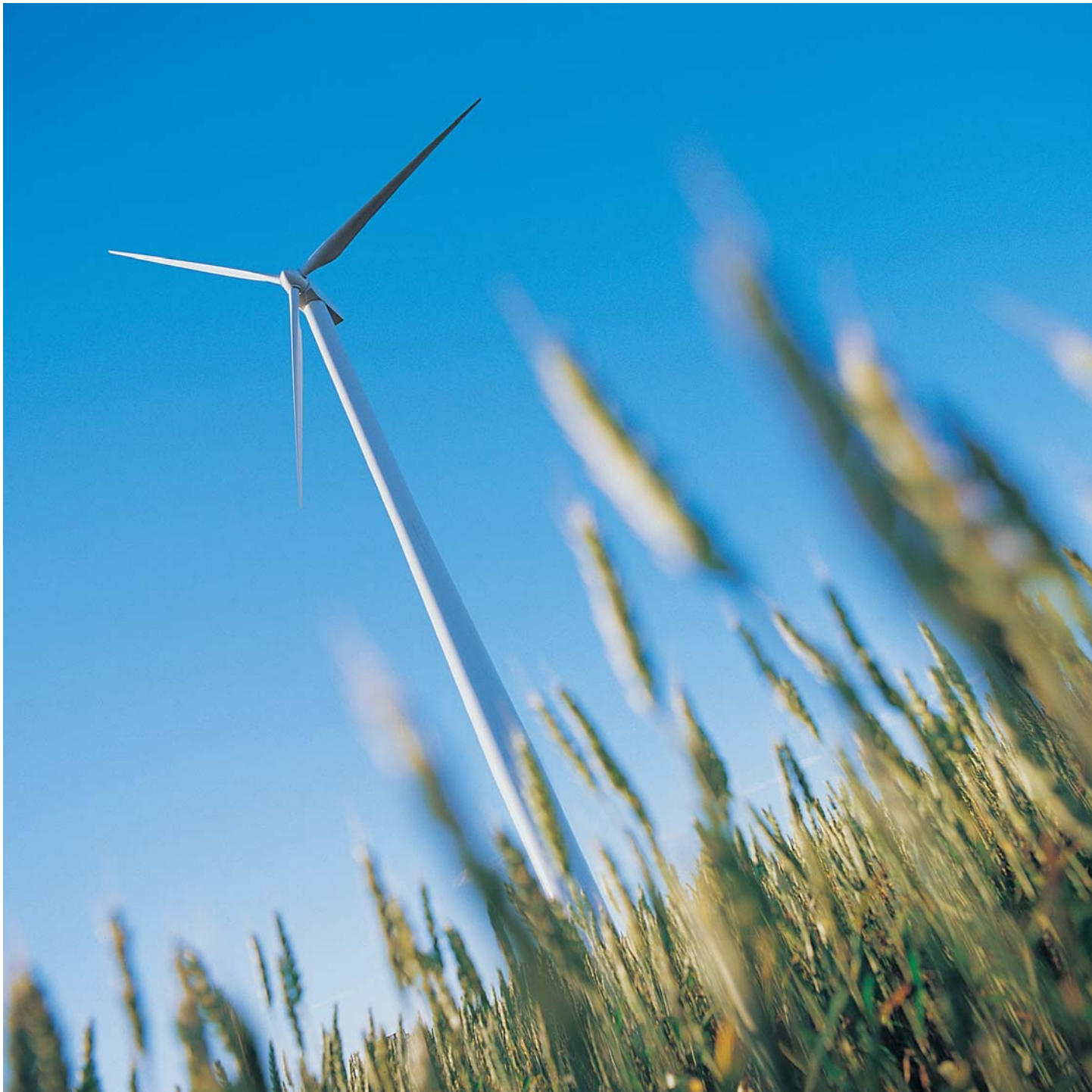
Énergie éolienne Sunbridge. Suncor Energy.
