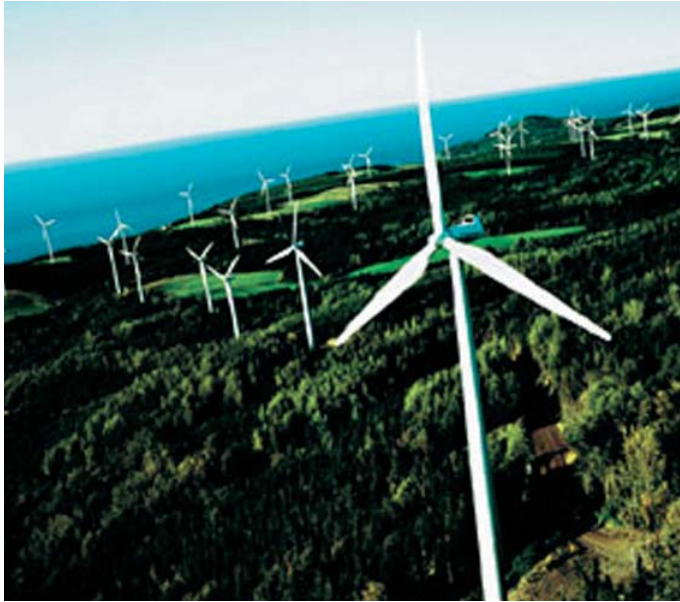
FIGURE 12 LE PARC ÉOLIEN LE NORDAIS, À CAP-CHAT (PROMOTEUR : AXOR)
