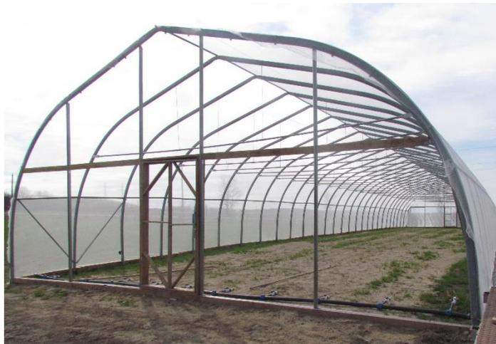
Structure de serre recouverte d'un filet anti-insectes
