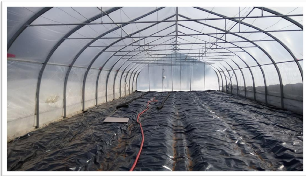
Figure 2. Vue de la serre de 9 x 27 m avec son recouvrement de film PVC. Le premier scénario consistait à appliquer de la vapeur sur le 1/4 de la surface à partir d'un diffuseur en 'H' placé sous la bâche. Quatre tuyaux de drainage perforés de 7 m de de longueur devaient permettre la diffusion de la vapeur. Sur la photo le dispositif est représenté au-dessus de la bâche
