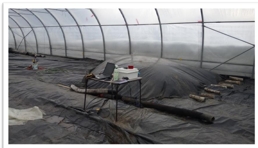
Figure 7. Méthode 3. Le dispositif de diffusion de vapeur est situé au centre d'une zone de 3,5 x 4 m. Afin de concentrer la vapeur sur cette surface restreinte, il était important de délimiter la surface avec des masses de retenue de la bâche (rondins de bois présents sur la photo) qui délimitaient la surface et la légère pression de vapeur pouvait être restreinte à cette surface.
