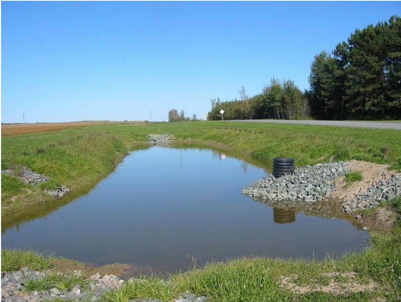
*L'étang peu de temps après sa construction en 2008. À droite se trouve l'avaloir perforé qui permet à l'étang de déverser graduellement l'eau de ruissellement qui s'y est accumulée prévenant ainsi les débits de pointe tout en favorisant la sédimentation des contaminants.*
