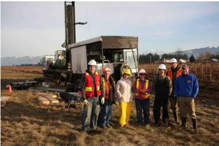
Forage des puits de surveillance des eaux souterraines dans l'aquifère d'Abbotsford. Crédit photo : Serban Danielescu, Ph. D. AAC Canada
