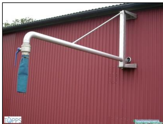
Potence orientable fixée à un bâtiment
