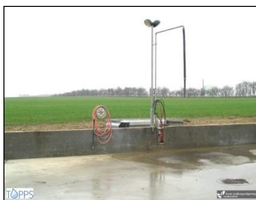
Potence orientable et dalle de béton
