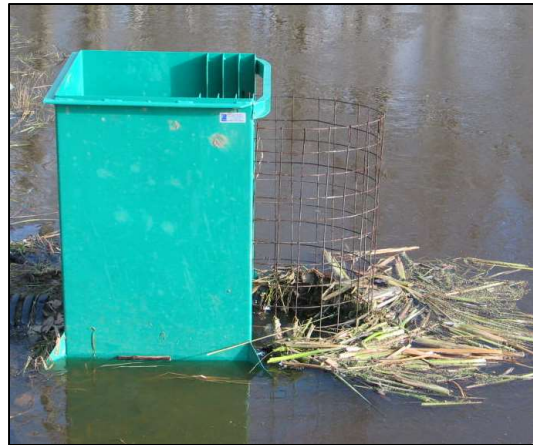
Structure de contrôle de l'eau
