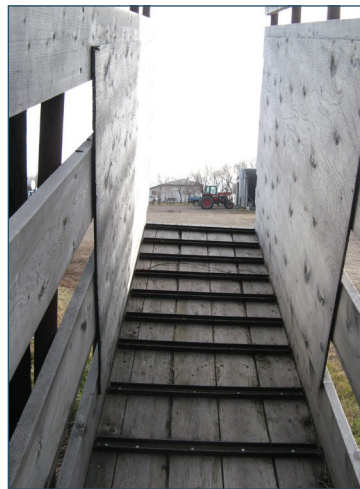
Figure 24. Un quai de chargement simple et efficace
