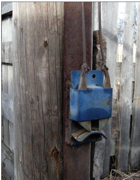
Figure 26. Exemple de mécanisme de fermeture
