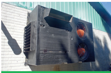
Échangeur de chaleur air-air ESA-3000 vu de l'extérieur.
