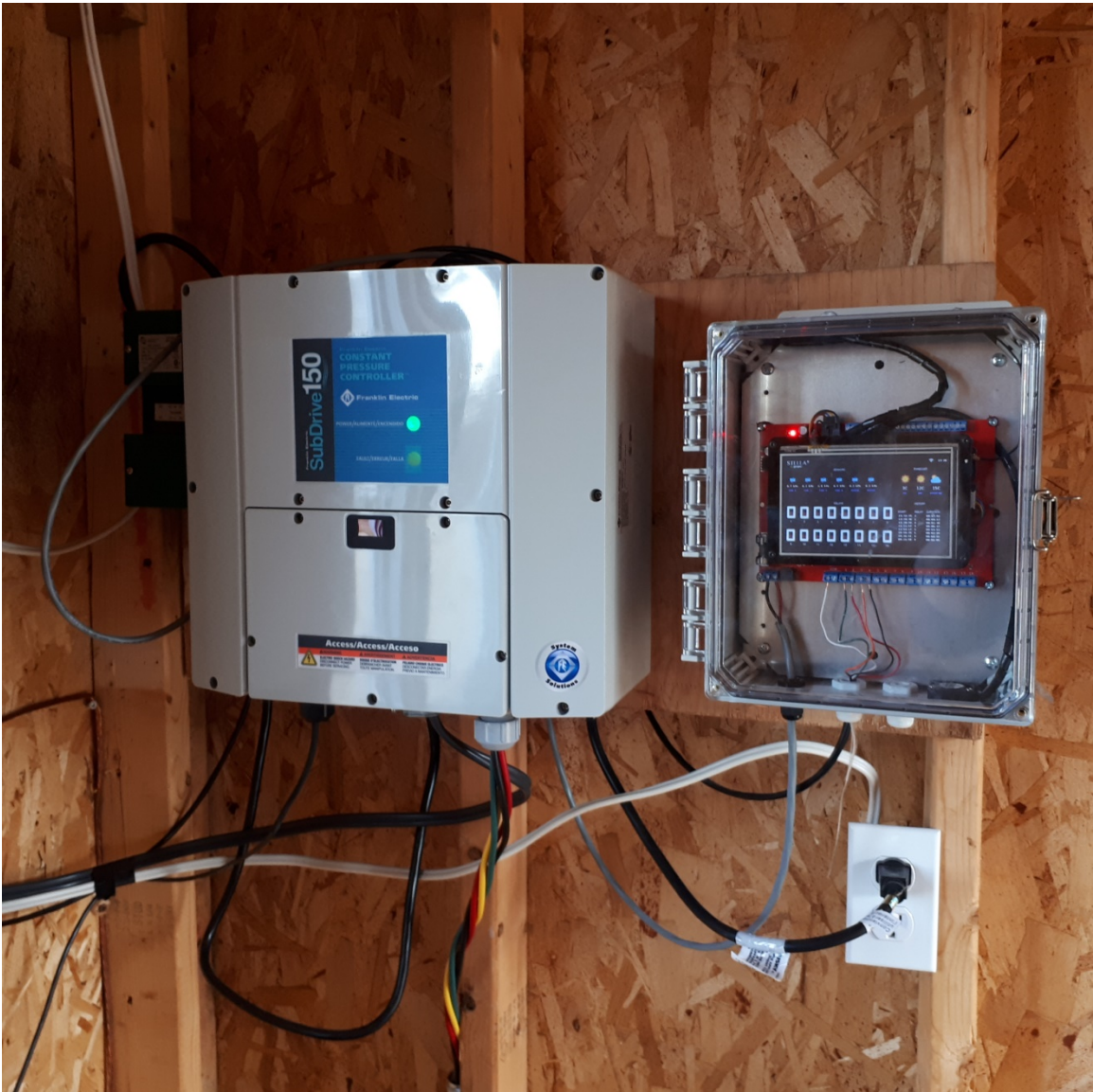
Photo 11 : Drive pour la pompe électrique (à gauche) et automate « Stella » de Gaspar (à droite) Source : Philippe-Antoine Taillon, MAPAQ
