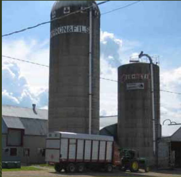
Silo coulé sur place de 20 x 64 pieds
