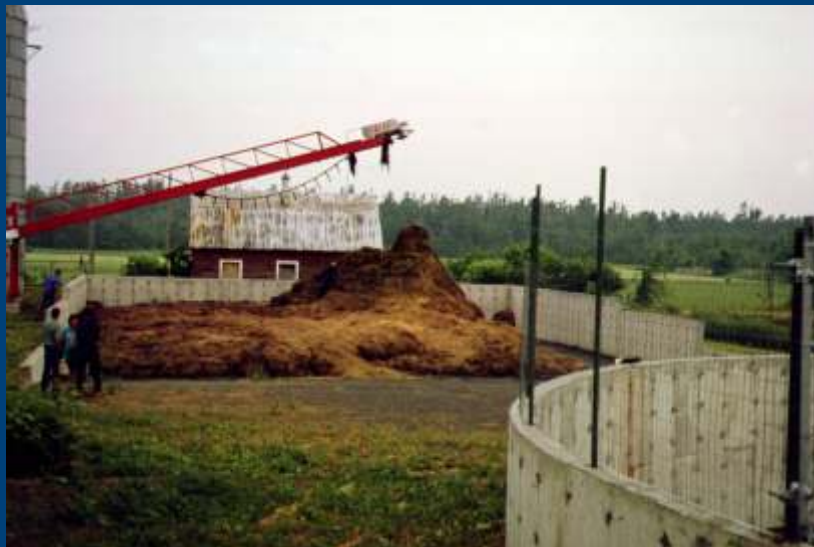
Ouvrage de stockage pour le fumier solide
