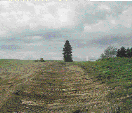
Aménagement d'une voie d'eau engazonnée
