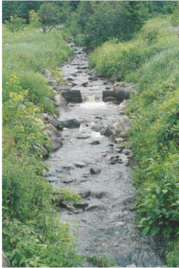
Végétation établie sur les talus d'un fossé
