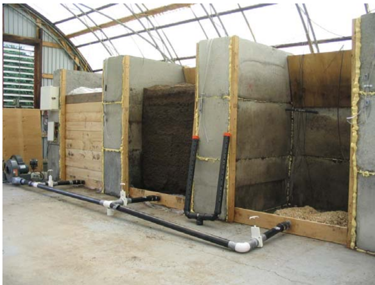
Figure 32: Montage des cellules de conditionnement
