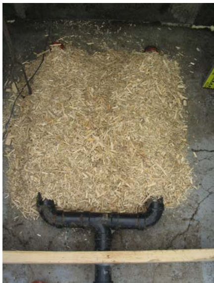
Figure 33: Montage du plénum de ventilation
