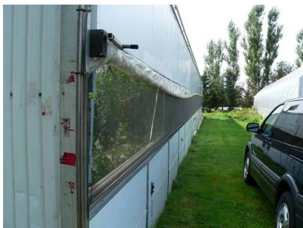
Photo 8 : Moustiquaire installée sur le côté ouvrant d'une serre jumelée.
