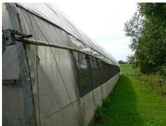
Photo 9 : Moustiquaire installée sur le côté ouvrant d'une serre individuelle.
