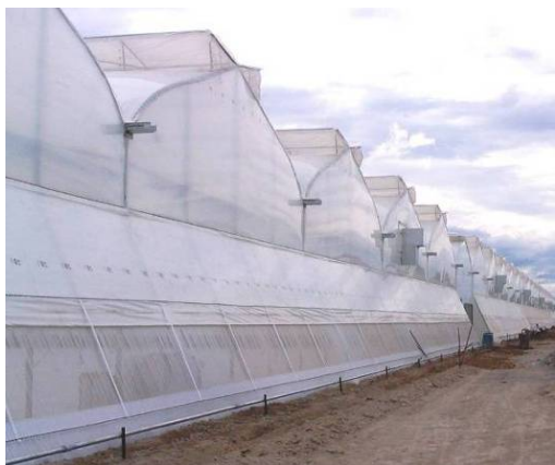
Photo 11 : Structure en porte-à-faux recouverte d'une moustiquaire sur le bout des serres jumelées.
