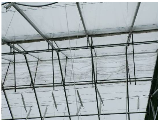
Photo 13 : Moustiquaire installée sur la ventilation naturelle au toit; ici, l'ouvrant est ouvert au maximum afin que l'on puisse mieux distinguer la moustiquaire pour la photo.
