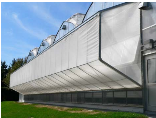
Photo 15 : Serres de recherche de l'Environnement de l'Université Laval à Québec; ces serres sont « à l'épreuve des insectes », même des thrips. On peut distinguer la moustiquaire en accordéon sur les toits ouvrants et la boîte de ventilation avec moustiquaire sur le bout des serres.
