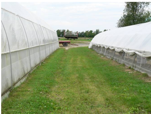
Photo 7 : Serres équipées de moustiquaires sur les côtés ouvrants; elles sont maintenues par des « polylocks ».
