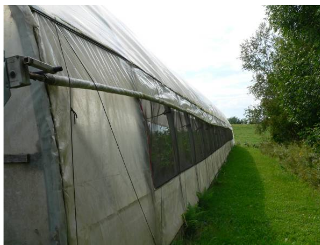
Photo 8 : Serre-tunnel équipée de moustiquaires sur les côtés ouvrants.
